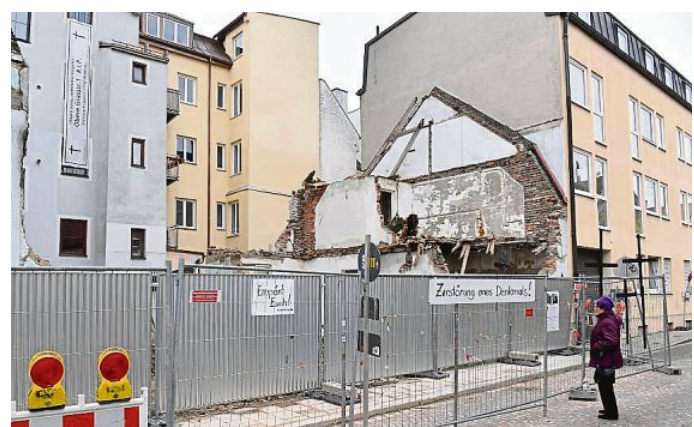
Die Giebelwände des abgerissenen Uhrmacherhäusls sollen mit Holzkonstruktionen gesichert werden. FOTO: MARCUS SCHLAF
